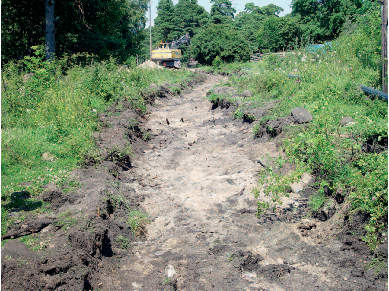
Schaktet intill den förmodade fornlämningen väster om Gannarve gård. Den svaga höjden till höger i bilden innehåller en diffus stenhög som antagits möjligen vara en fornlämning. Vid schaktningen framkom en mindre stensamling liggande på slänten mot den forna åker som ligger söder om den svaga höjden. Det rör sig uppenbarligen om röjningssten från åkern. Foto Dan Carlsson.
